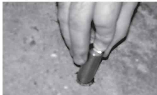
7. Fissare gli assi di acciaio inossidabile forniti a corredo per mezzo dei buloni. Ogni asse di acciaio inossidabile deve essere perfettamente dritto.
