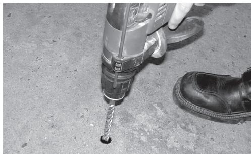
6. Voorzie de boorgaten ( $\varnothing$  12 mm) in de grond waar u ze hebt aangeduid. Maak dat de gaten voldoende diep zijn zodat de pluggen vol-ledig in de grond passen.
