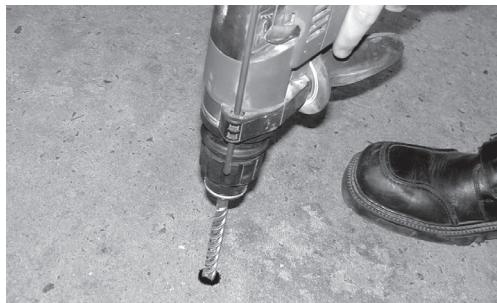
6. Forez les trous ( $\varnothing$  12 mm) dans le sol aux endroits indiqués. Veillez à ce que la profondeur des trous corresponde a. Aux dimensions des chevilles fournies.
