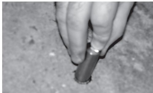
7. Befestigen Sie jetzt die mitgelieferten Inox Achsen, indem Sie sie mit Holzschraubenbolzen festschrauben. Sorgen Sie dafür, dass die Inox Achsen schön aufrecht stehen.
