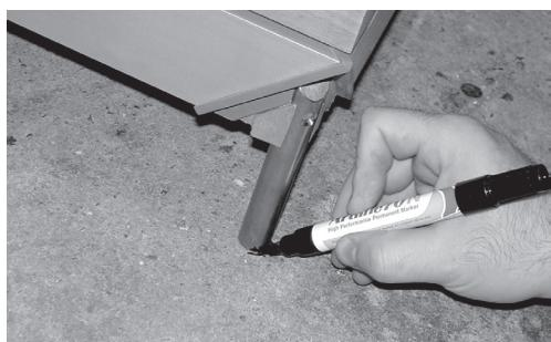
5. Markieren Sie die Stelle, an der die Stäbe auf den Boden treffen. Stellen Sie die Bank oder den Tisch an einer anderen Stelle, wenn Sie hiermit fertig sind. Befestigen Sie die Tischbeine wie in der ExTempore Gebrauchsanweisung beschrieben.
